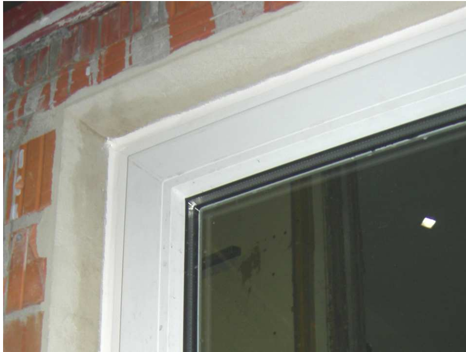
Bild 1 Abdichtung innen mit Fugendicht Innen + PE-Rundsnur (seitlich und oben).
